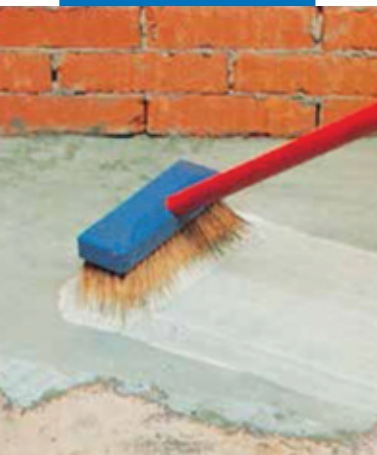
Нанесение цементного раствора с добавлением Planicrete
