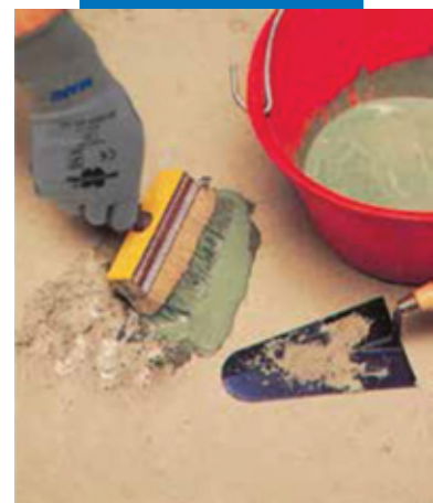
Ремонт пола с нанесением цементного раствора
