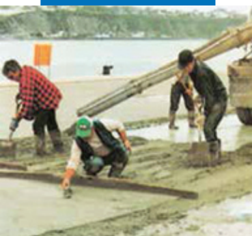
Цементная стяжка с добавлением Planicrete - Вье Порт, Квебек, Канада
