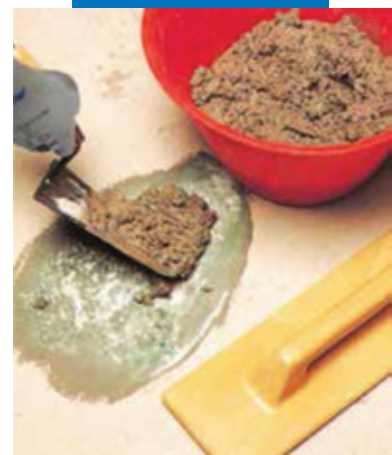
Ремонт пола: нанесение строительного раствора
